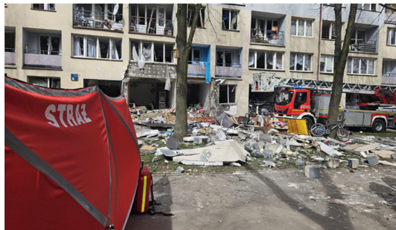
Wybuch gazu w budynku wielorodzinnym fot. strona KG PSP
