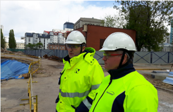
▲ Wizyta na budowie Browarów Warszawskich. Na zdjęciu Jacek Szymanek, Członek Zarządu Mostostal Warszawa wraz z Markiem Słowikiem, kierownikiem robót
