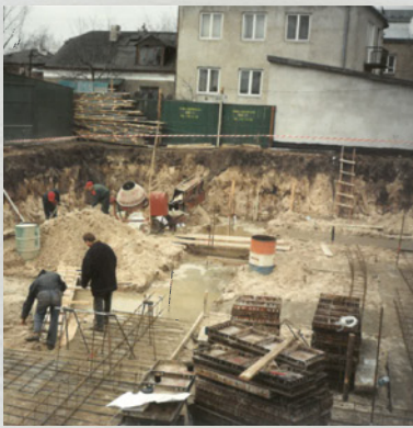
Budowa siedziby, ul. Makowska 95
